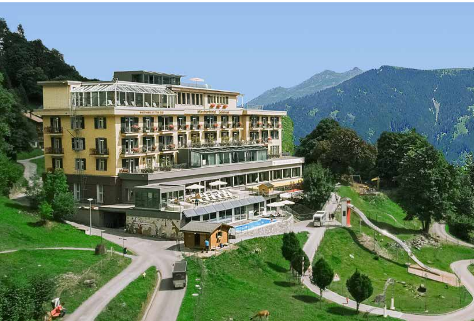
Ein grosses Haus, das ursprünglich als Grandhotel gebaut wurde und heute in 42 Zimmern seine grossen und kleinen Gäste beherbergt. Neben einem Speisesaal fürs Morgen- und Abendessen gibt es einen Kinderspeisesaal und ein Tages- und Mittagsrestaurant.
